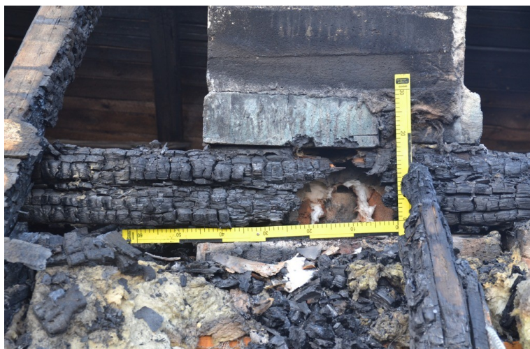
Pohled na vazný trám procházející komínovým tělesem
